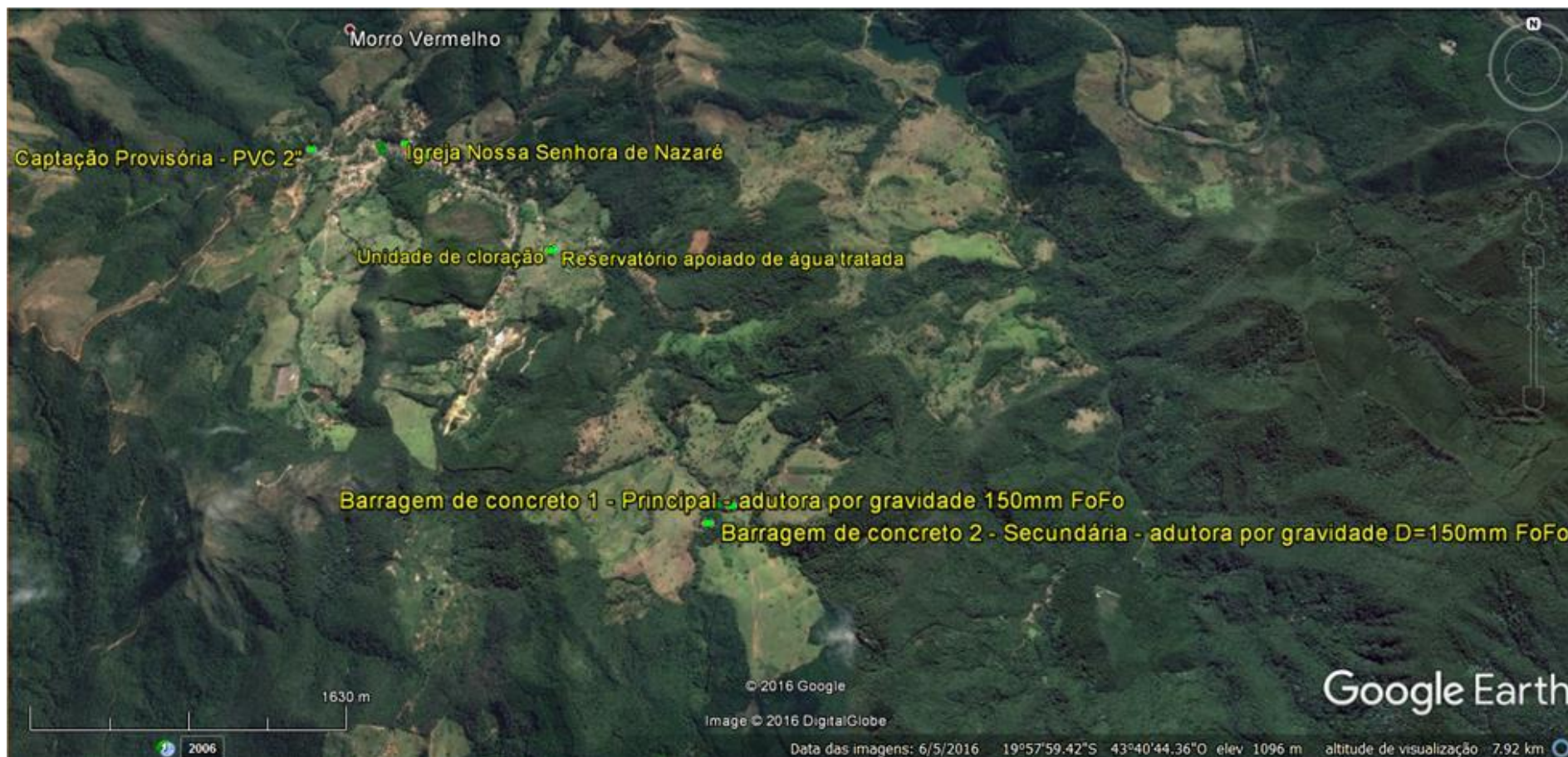
Figura 7.3 – No topo o centro urbano de Morro Vermelho, no centro a ETA e embaixo as Captações Principal, Secundária e desativada e o córrego Santo Antônio.
