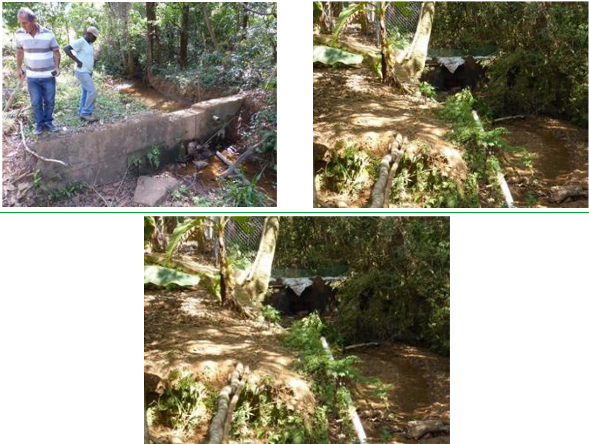
Figura 7.8 – Captação principal, secundária e provisória, respectivamente.
