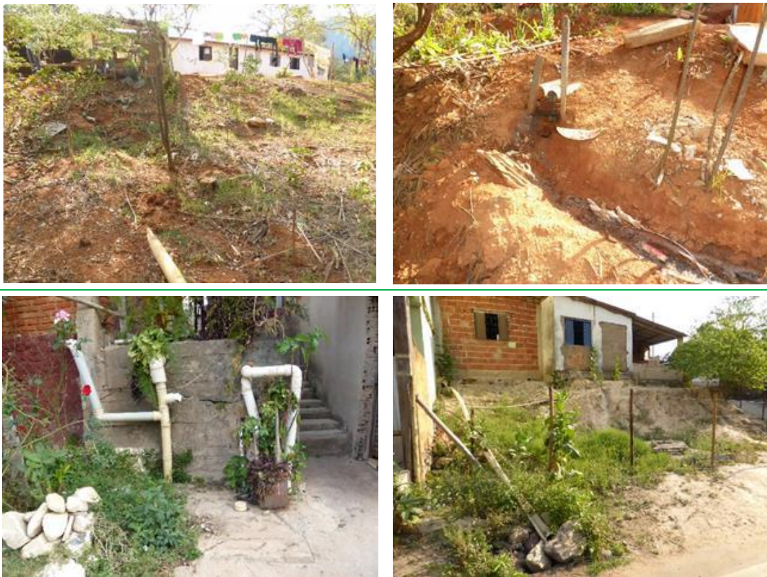
Figura 6.6 – Lançamento do esgoto em corpo hídrico (linha 1) e lançamento em fossa rudimentar coletiva e individual (linha 2, respectivamente).
