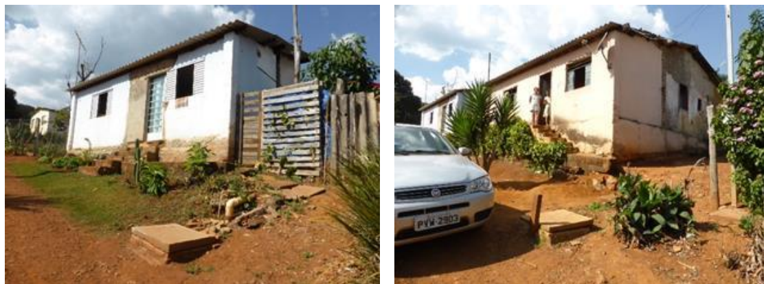
Figura 6.5 – Residências com caixa onde é feita a ligação à rede coletora).
