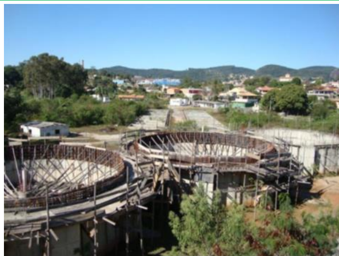
Figura 3.10 – Reator UASB e filtro biológico percolador (em construção), respectivamente.
